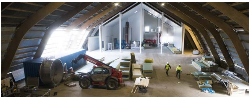
Et kig ind i bioraffinaderiet. Bagerst ses det kommende procesanlæg
